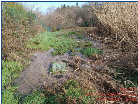
Figure 46 : Débordement du premier étage de la STEP de Lemps
