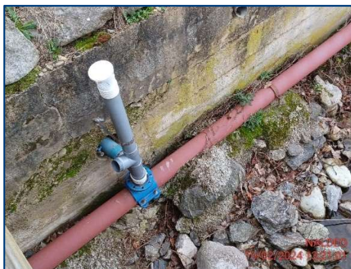
Figure 47 : Aménagement réalisé lors des mises en charge de la conduite afin d'éviter le débordement d'eaux usées sur le branchement du camping
